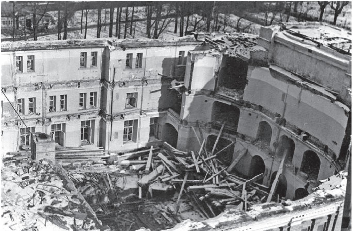
**Фото 2. Реконструкция здания театра оперы и балета им. П.И.Чайковского выполненная в 1950 году. Демонтаж перекрытий центральной части здания**
